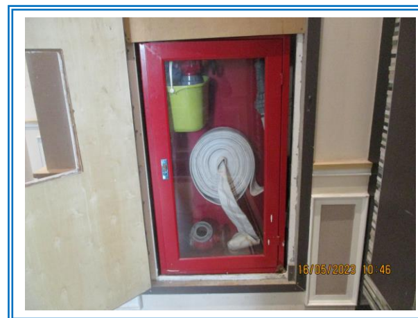
รูปที่ 3-40 ตู้เก็บสายฉีดน้ำดับเพลิงและหน้ากากป้องกันควันไฟในห้องพัก
