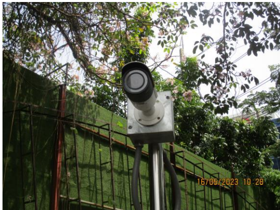
รูปที่ 3-49 ติดตั้งระบบกล้องวงจรปิด CCTV ภายนอกอาคาร
